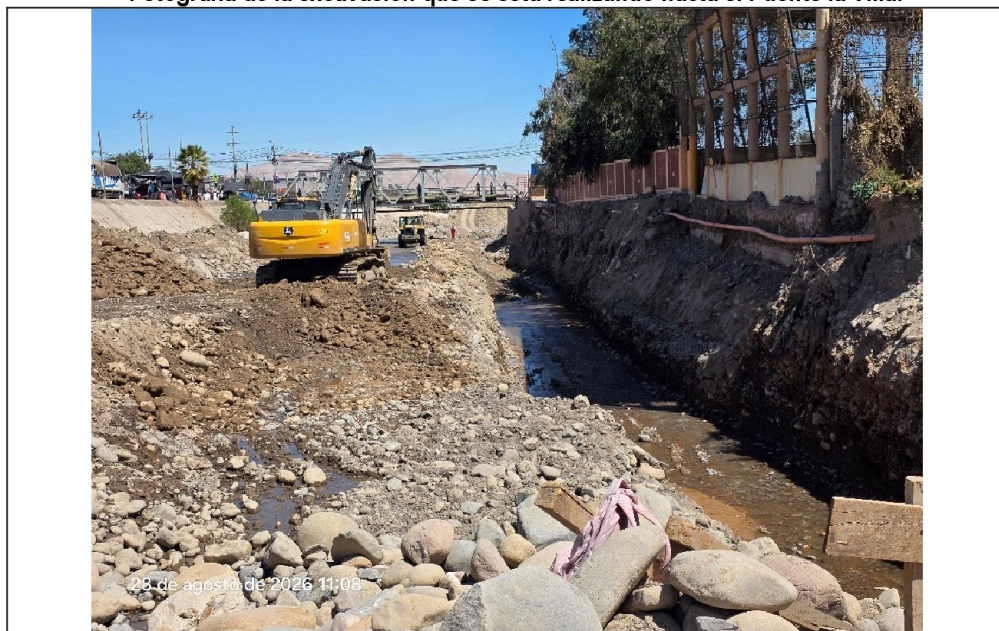
Imagen n.º 20: Fotografía de la excavación que se está realizando hasta el Puente la Villa en la progresiva 3+990.
