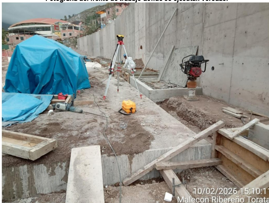
Imagen n.º 1 Fotografía del frente de trabajo donde se ejecutan veredas.
