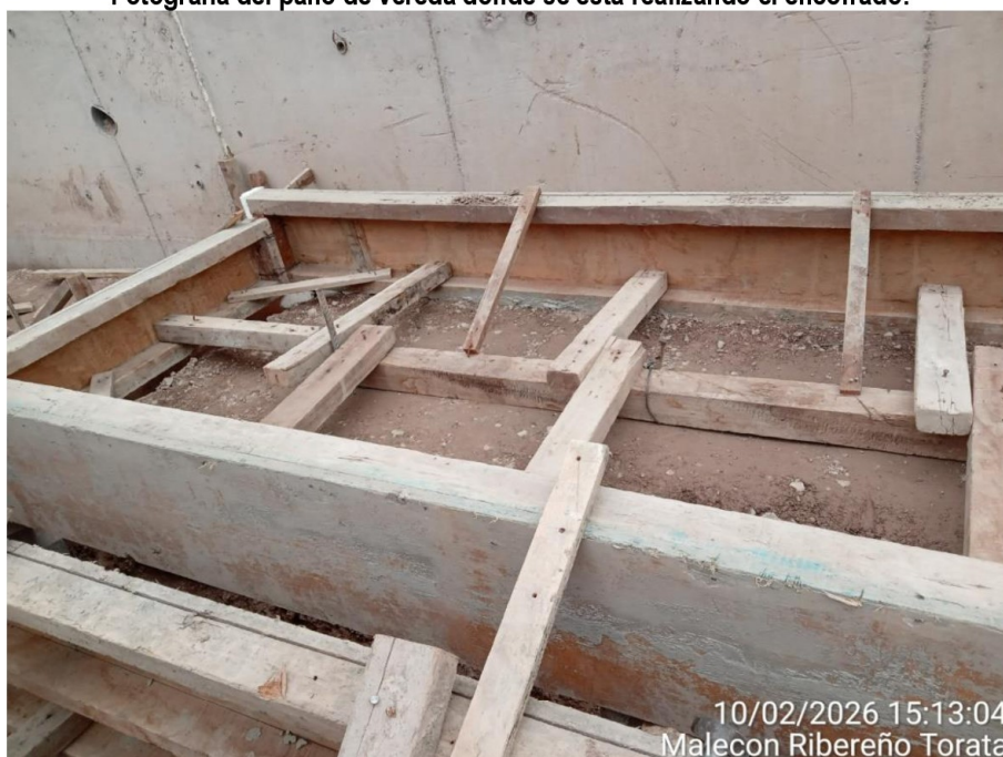
Imagen n.º 2 Fotografía del paño de vereda donde se está realizando el encofrado.
