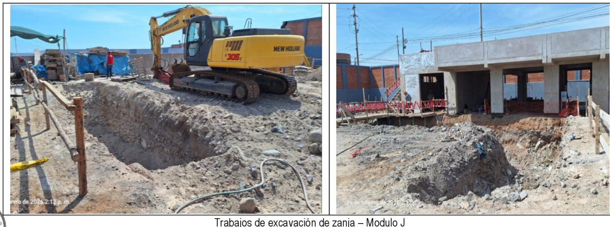
Trabajos de excavación de zanja – Módulo J
