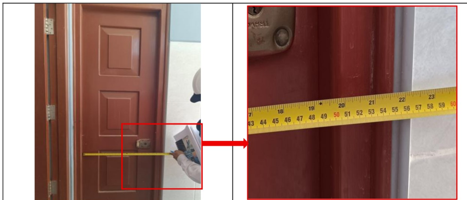
Imagen n.º 13 Ancho del vano de la puerta de almacén del módulo J (56 cm)
