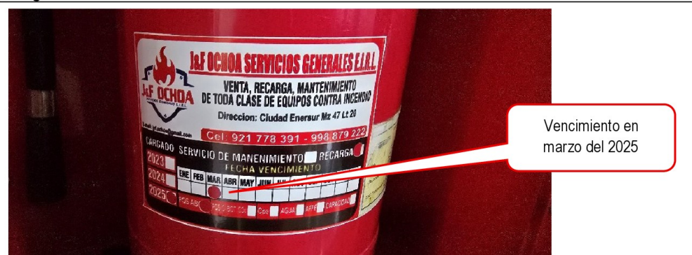
Imagen n.º 13: Etiqueta de mantenimiento y recarga adherida al extintor, en la que indica como vencimiento en marzo de 2025.
