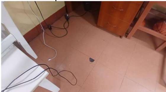
Imagen n.º 35 Pisos presentan rotura de vinilo
