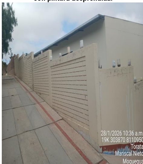
Imagen n.º 7 Pintura de cerco perimétrico con manchas y con pintura desprendida.
