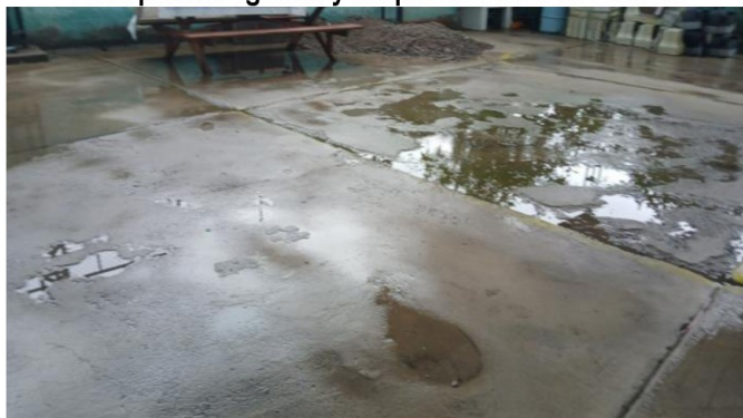
Imagen n.º 37 Losa presenta grietas y desprendimiento de material
