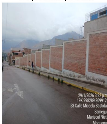
Imagen n.º 19 Pintura de cerco perimétrico manchada y con pintura desprendida.
