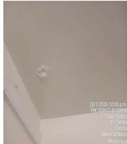
Imagen n.º 10 Techo presenta desprendimiento de pintura causado por la humedad y agua acumulada en el techo
