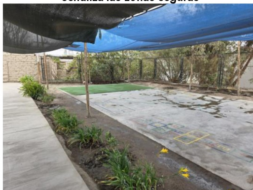
Imagen n.º 64 Cobertura desgastada y dañada; además, patio central no señaliza las zonas seguras
