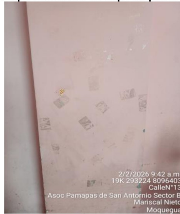
Imagen n.º 39 Paredes presentan manchas y desprendimiento de capa de pintura.
