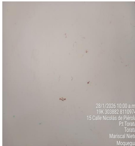
Imagen n.º 9 Paredes presentan manchas y desprendimiento de capa de pintura.
