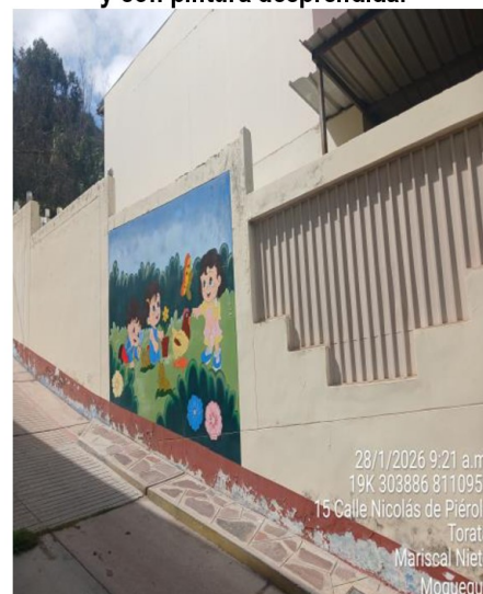
Imagen n.º 8 Pintura de cerco perimétrico con manchas y con pintura desprendida.
