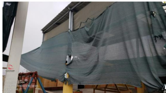
Imagen n.º 48 Deterioro de cobertura flexible
