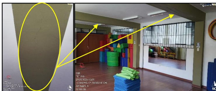
I.E.I. n.° 154 Elisa Rivera Observación: Presencia de Fisuras en vigas y losa de las Aulas de Psicomotricidad.
