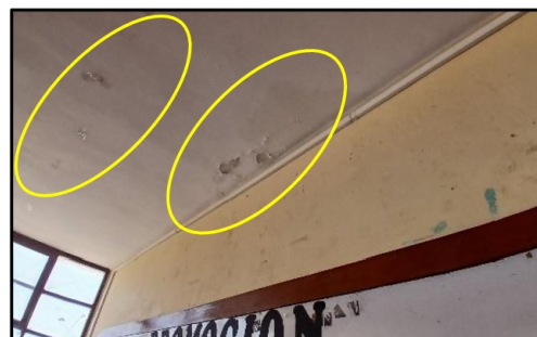
I.E. Mercedes Cabello de Carbonera Observación: Humedad en techos
