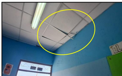
I. E. Jorge Basadre Grohmann Observación: Perfiles doblados y sin fijación
