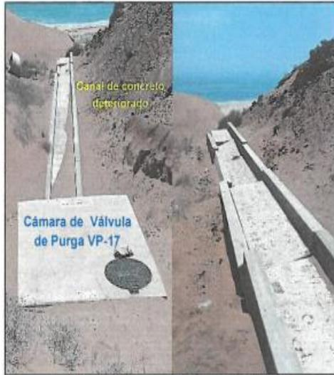
**Fotografía n.º 1:** Canal de evacuación con mampostería de concreto correspondiente a la cámara de válvula de purga VP-17, ubicada en la progresiva 14+095, fue fundada sobre terreno natural de arena y limos.
