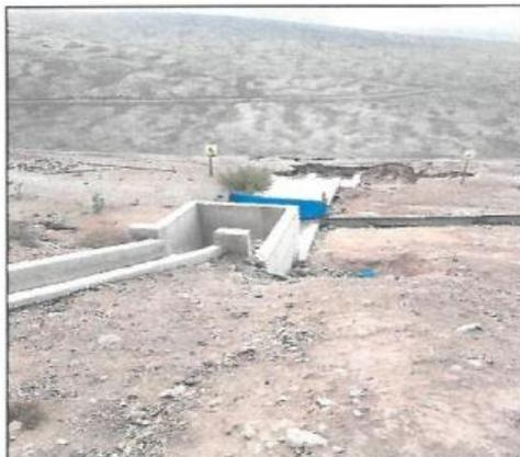
**Imagen n.º 2:** Cámara, canal de evacuación y badén de concretos ejecutados para el transporte, descarga y evacuación de los sedimentos sólidos en suspensión, decantados y retenidos como excedencias de agua del reservorio hacia una quebrada.
