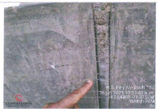
Imagen n.º 34: Relleno de junta en sobrecimiento de cerco perimétrico.
