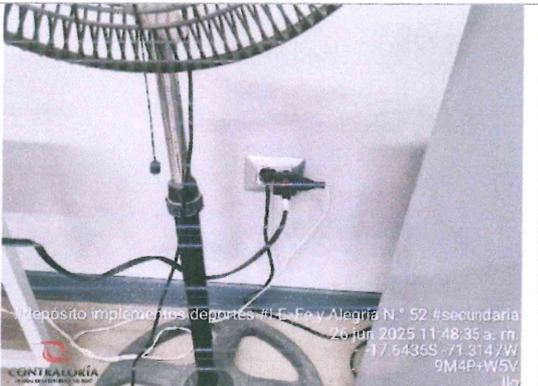
Imagen n.° 12: Defectos en conexión eléctrica y sin contacto a tierra.
