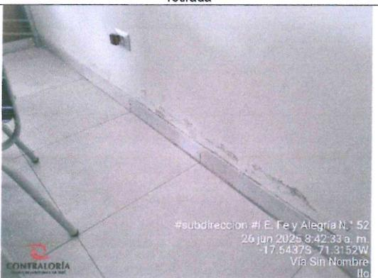
Imagen n.° 21: Eflorescencia debido a humedad en suelo de fundación.
