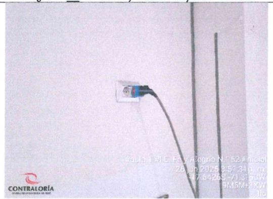
Imagen n.º 40: Conexión eléctrica sin contacto a tierra.
