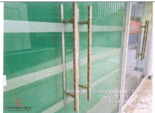
Imagen n.º 38: Oxidación y deterioro en jalador cromado.
