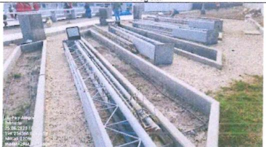
Imagen n.° 19: Estructura metalica de la cobertura de lona retirada
