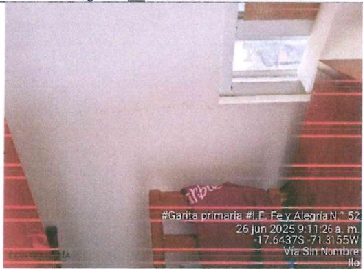
Imagen n.° 25: Fisura en esquina inferior de ventana.
