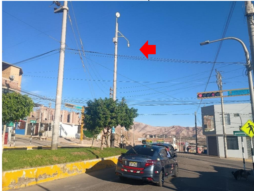
Imagen n.º 20 Cámara ubicada en Av. Mariano Lino Urquieta con Av. San Antonio Sur.
