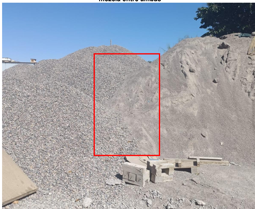
Imagen n.º 2 Deficiente almacenamiento de la piedra chancada y la arena gruesa genera su mezcla entre ambas
