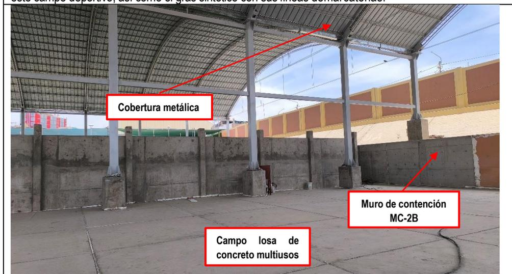
Como podemos apreciar en esta imagen de 27 de noviembre de 2024 el campo deportivo multiusos ya se encontraba construido, por lo que ya se habían ejecutado los trabajos de relleno con suelo - cemento, trabajos de rellenos en muro de contención el cual ya se encontraba ejecutado y del mismo modo ya se encontraba instalada la cobertura metálica de este campo deportivo, quedando pendiente los trabajos de pintura.
