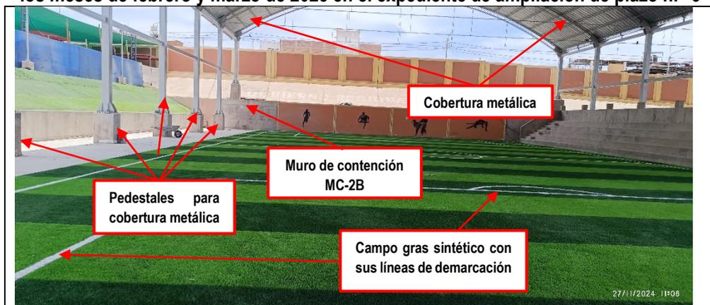
Como podemos apreciar en esta imagen de 27 de noviembre de 2024, el campo deportivo de Grass sintético ya se encontraba instalado, por lo que ya se habían ejecutado los trabajos de relleno con suelo - cemento, excavación de zanjas para los pedestales y hasta se había instalado la cobertura metálica de este campo deportivo, así como el gras sintético con sus líneas demarcatorias.
