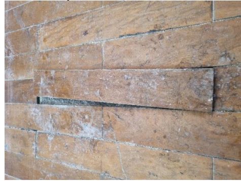
Fecha de la toma fotográfica: 11 de febrero de 2025 en la I.E. Juan Pablo II en el distrito de Puquina.
