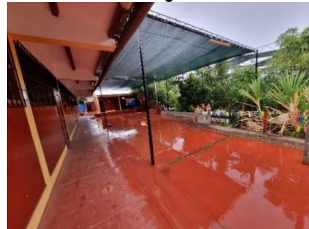
Imagen n.º 61 Patio principal de la IE 43087, no se encuentra señalizada como zona segura en caso de sismos
