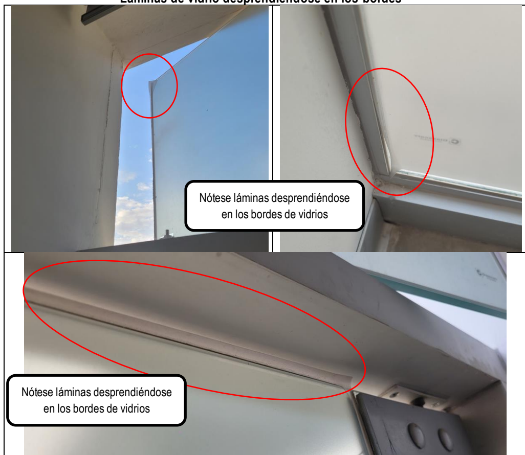
Imágenes n.ºs 3, 4, 5, 6 y 7 Láminas de vidrio desprendiéndose en los bordes
