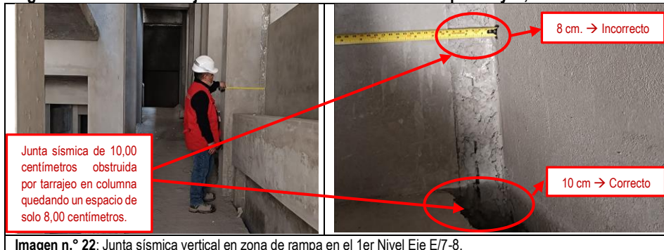
Imagen n.º 22: Junta sísmica vertical en zona de rampa en el 1er Nivel Eje E/7-8.
