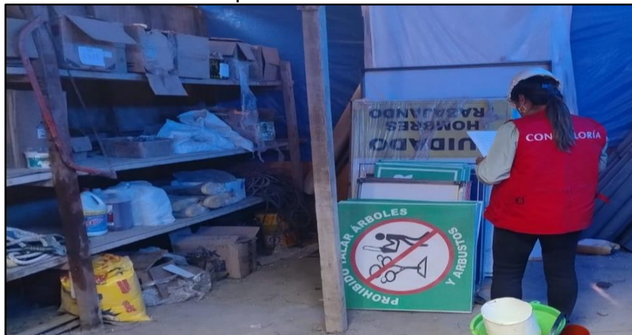
Imagen n.º 8 Señales preventivas en almacén de obra
