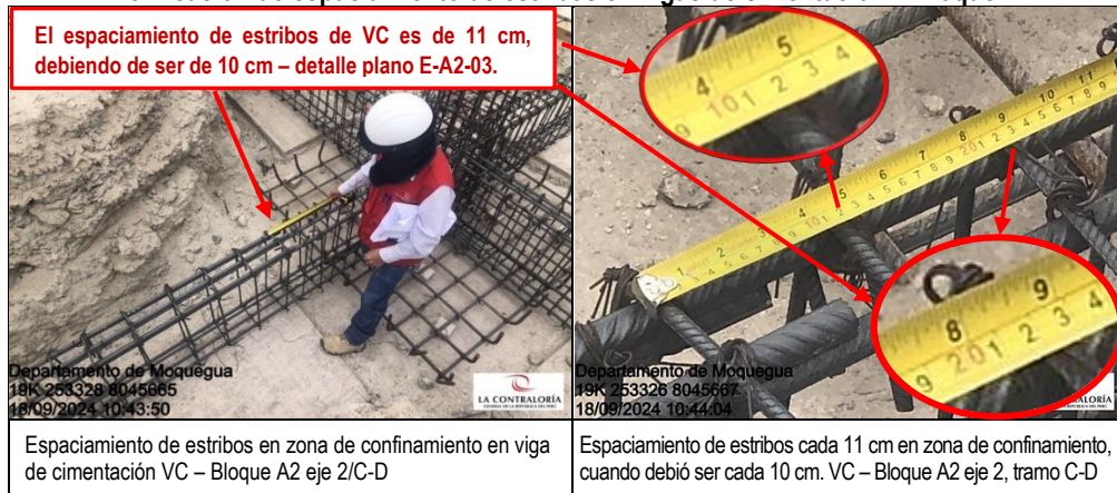
Imágenes n.º 43 y n.º 44 Verificación de espaciamiento de estribos en vigas de cimentación – Bloque A2.
