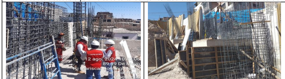
Armado de acero estructural para muros de contención colindantes con la calle Loreto.
