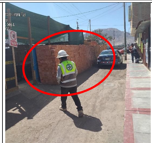
Se viene almacenando ladrillos de cerámica en plena vía pública (pasaje Libertad), generando el riesgo de pérdidas, considerando que estos bienes aún no se viene utilizando en la ejecución de la obra.
