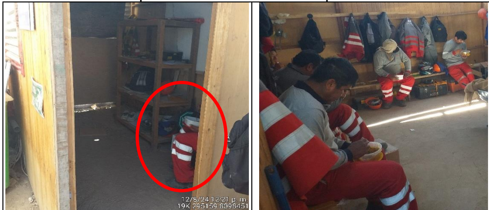
El vestuario de damas no cuenta con piso de cemento (solado) o similar, además no cuenta con casilleros para cada trabajador y viene siendo utilizado como comedor.
