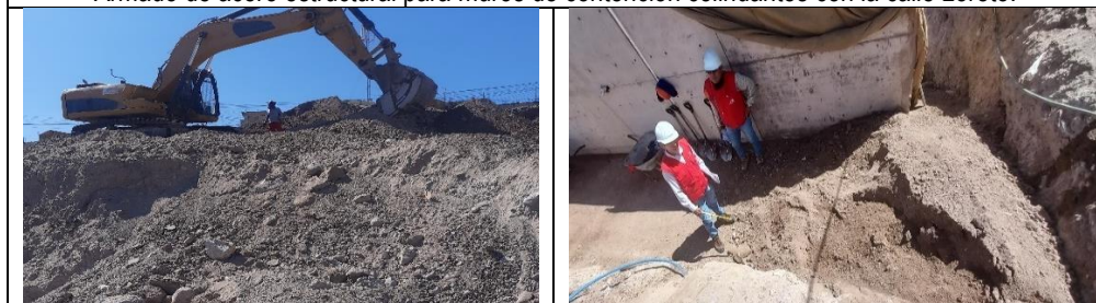
Trabajos de acarreo de material propio para rellenos controlados, asimismo, se aprecia la falta de culminación de los trabajos de rellenos controlados para los muros de contención de la calle Mercedes C. Carbonera.
