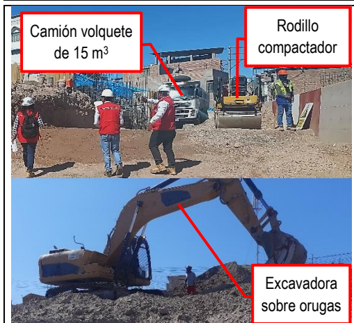
No existe un área de parqueo de maquinarias de construcción, por lo cual, se advierte que la maquinaria pesada se viene estacionando en las áreas de trabajo de la obra, originando el riesgo de accidentes de tránsito.
