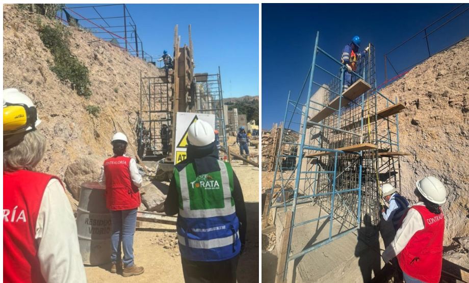
Imagen n.º 1 Trabajos de encofrado y acero en muros de contención
