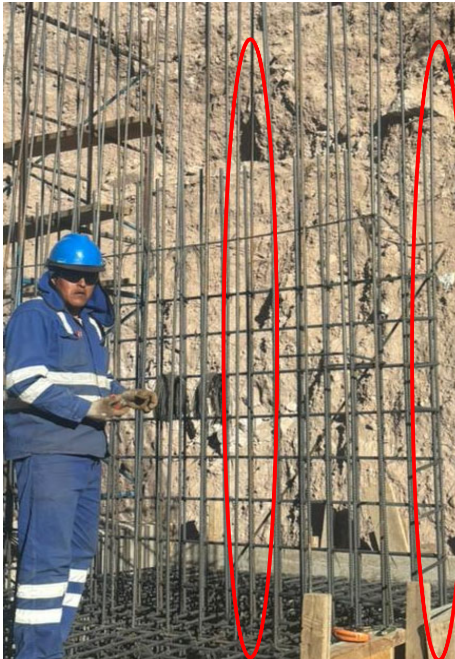
Imagen n.º 2 Aceros de refuerzo de los muros de contención
