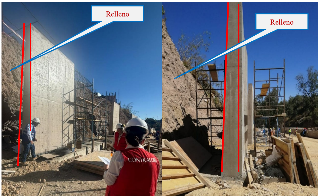
Imagen n.º 8 Muros de contención ejecutados
