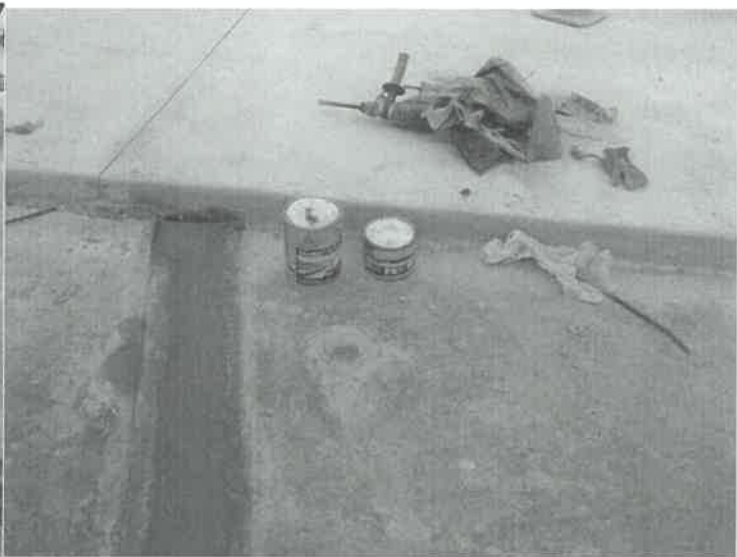
Relleno con mortero y acabado en zona de juntas. Responsable de obra informo que posterior a ello se ejecutara juntas de dilatación mediante corte en concreto.
