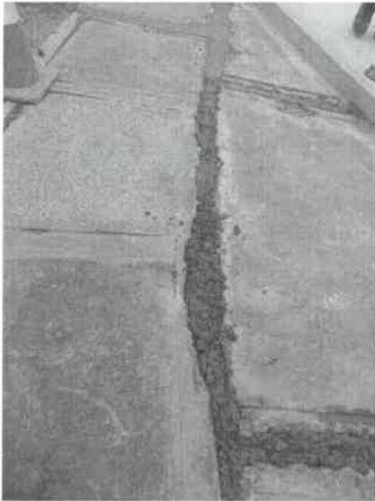
Relleno con mortero y acabado en zona de juntas. Responsable de obra informo que posterior a ello se ejecutara juntas de dilatación mediante corte en concreto.
