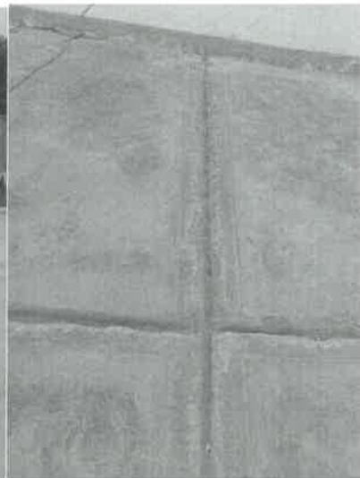
Detalle de junta de dilatación/sardinel existente
