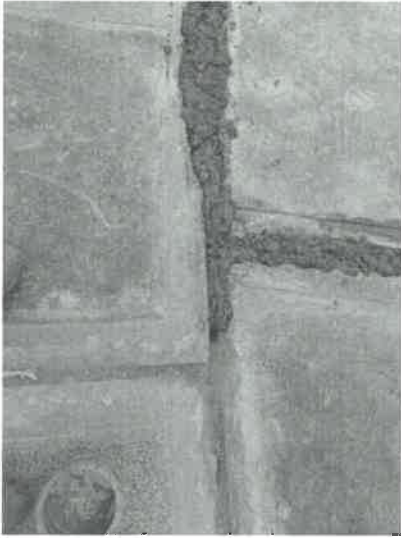
Relleno de juntas de dilatacion con mortero
