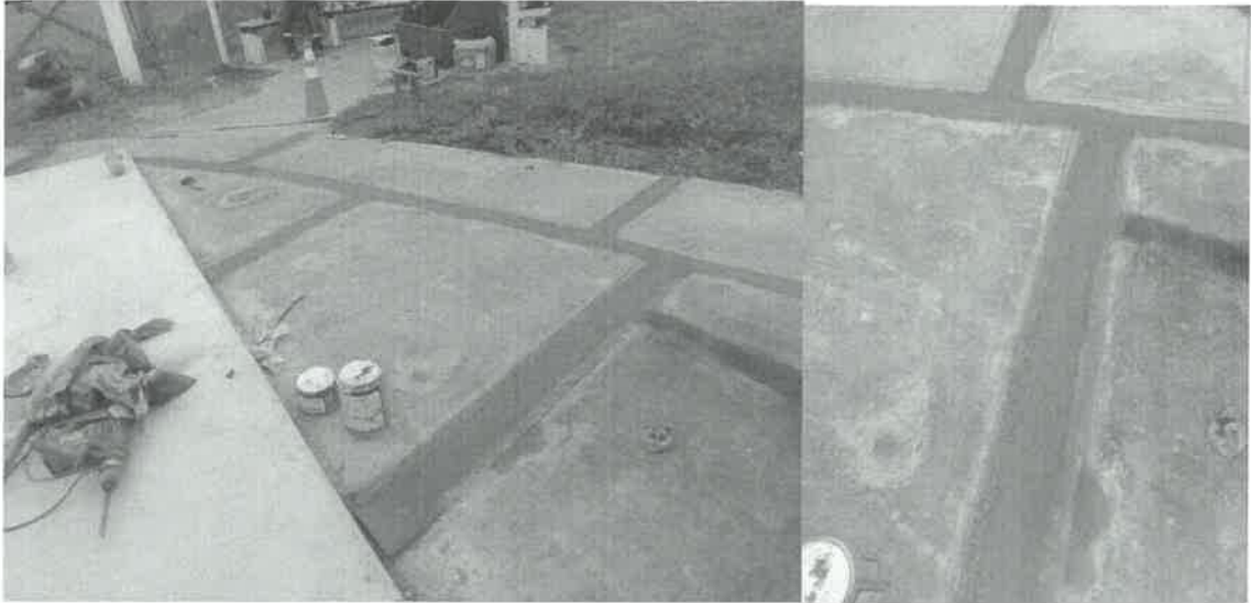
Acabado en juntas de dilación y sardineles.
