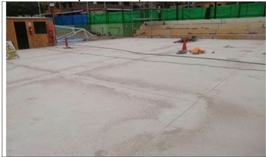
Imagen n.º 1 Se ejecuto nueva losa deportiva de concreto
