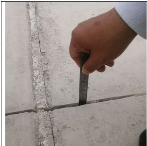
Imagen n.º 5 Junta de dilatación obtenidas mediante corte en concreto.
