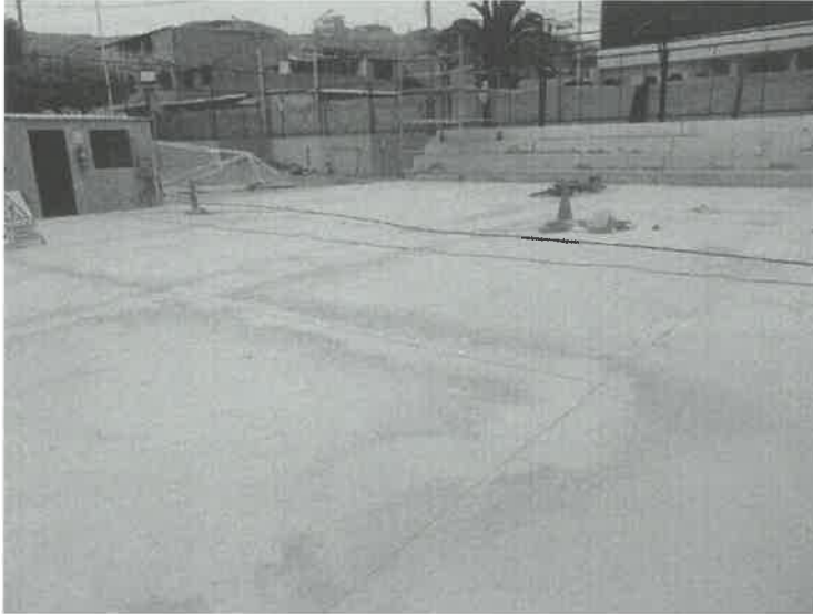
Losa de concreto con cortes para dotarle de juntas de dilatación.
