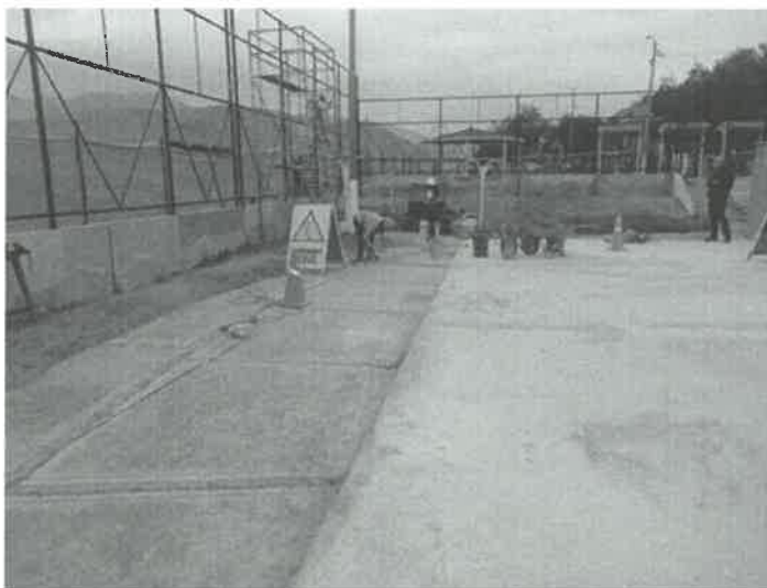
Mantenimiento de juntas de dilatación existentes en caminerías y veredas
