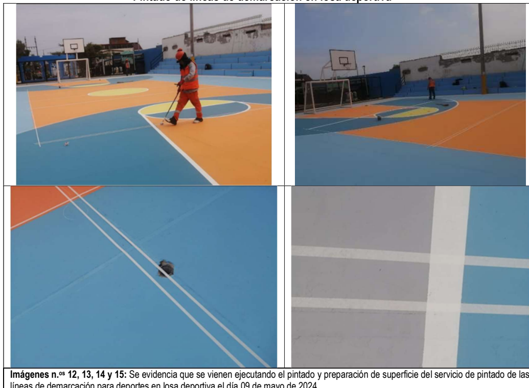
Imágenes n.ºs 12, 13, 14 y 15 Pintado de líneas de demarcación en losa deportiva
