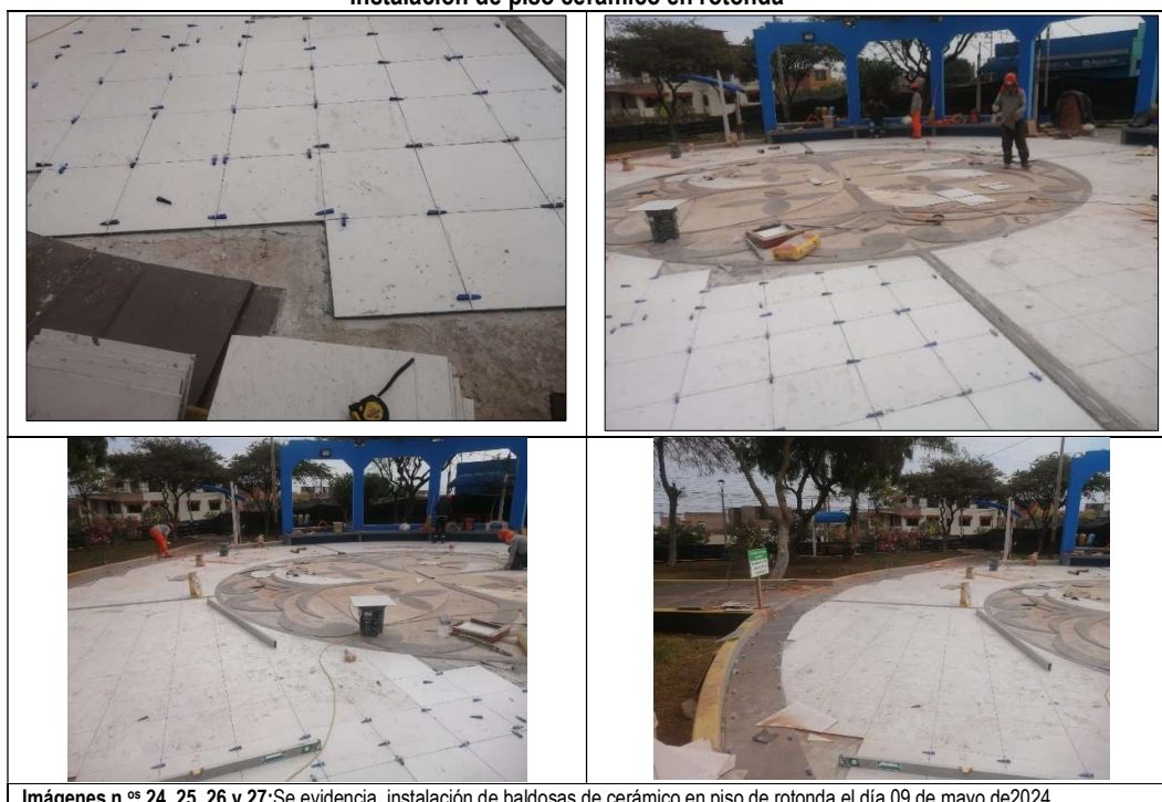
Imágenes n.ºs 24, 25, 26 y 27: Se evidencia instalación de baldosas de cerámico en piso de rotonda el día 09 de mayo de 2024
