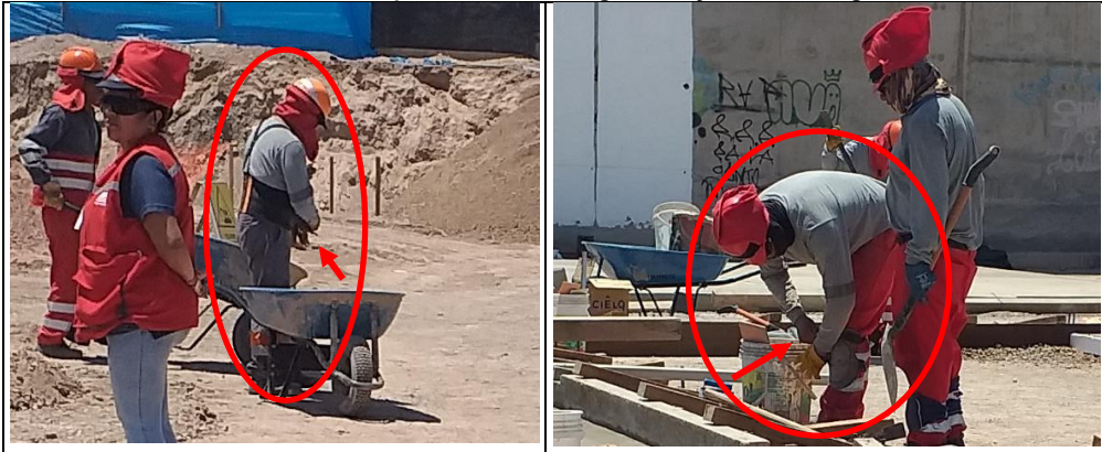
Trabajadores que venían laborando sin guantes de seguridad y que procedieron a colocárselos ante la presencia de los miembros de la comisión de control, durante la visita de inspección física.
