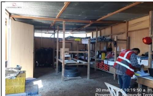
Almacén de materiales comunes con piso de tierra.
