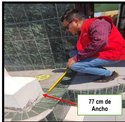
Toma Fotográfica n.º 6 Medida de ancho de rampa de Discapacitados
