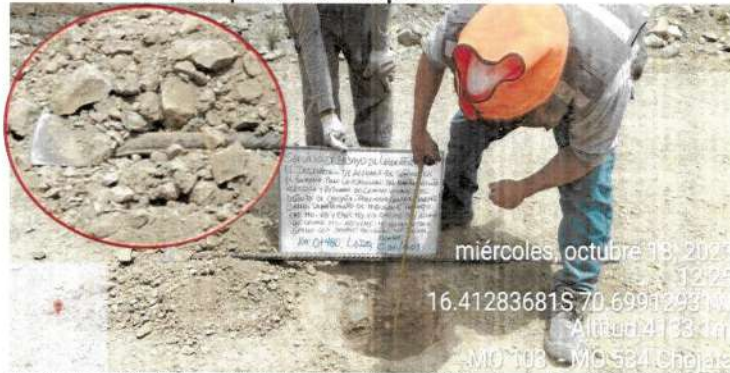
Imagen n.° 13 Extracción de muestra en la progresiva 0+480 Tramo Emp. MO-103 – Emp. MO-534
