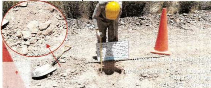
Imagen n.º 7 Extracción de muestra en la progresiva 1+340 Tramo Emp. MO-103 – Pachas
