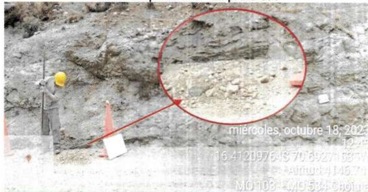
Imagen n.° 14 Extracción de muestra en la progresiva 1+250 Tramo Emp. MO-103 – Emp. MO-534
