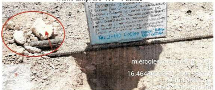
Imagen n.º 8 Extracción de muestra en la progresiva 2+140 Tramo Emp. MO-103 – Pachas
