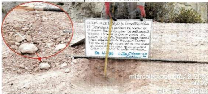
Imagen n.º 11 Extracción de muestra en la progresiva 4+900 Tramo Emp. MO-103 – Pachas
