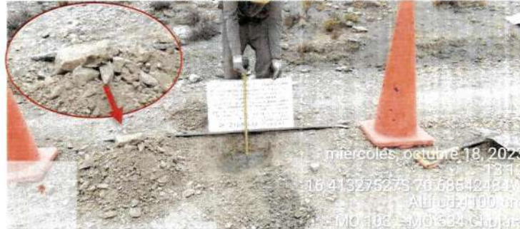
Imagen n.° 15 Extracción de muestra en la progresiva 2+080 Tramo Emp. MO-103 – Emp. MO-534
