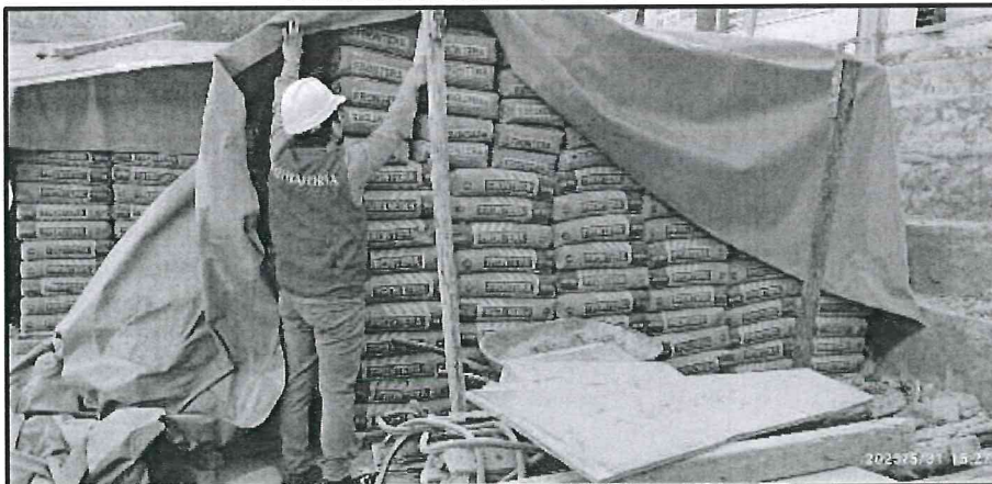
Imagen n.º 25 Condiciones de almacenamiento del cemento
