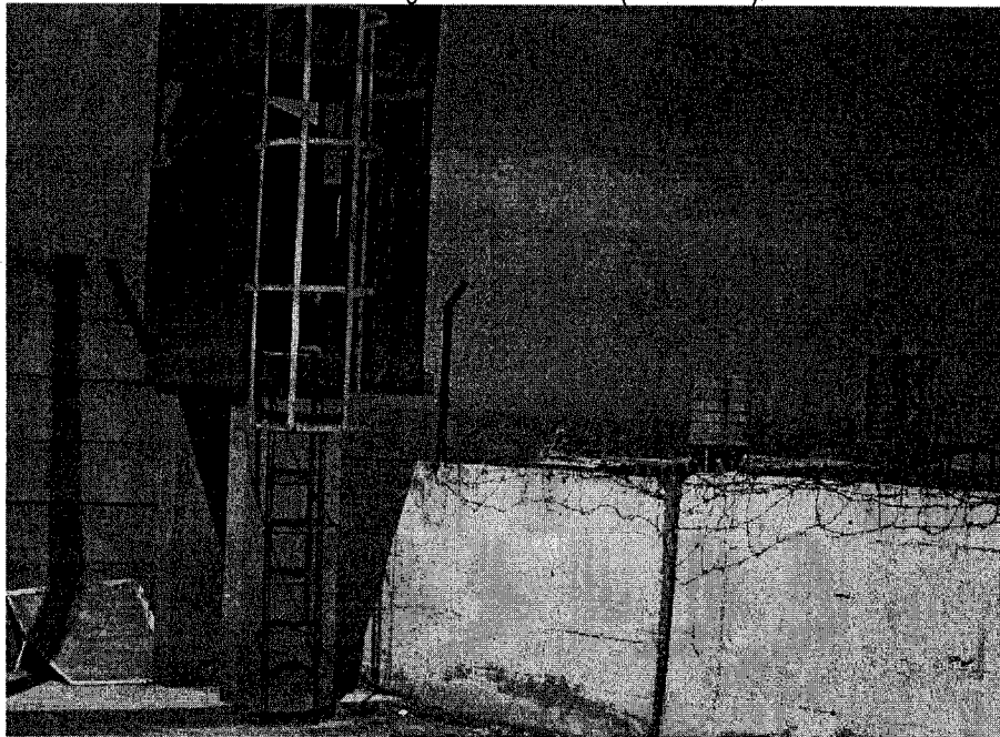
Fotografía n.º 4 Torreón vigilancia norte calle 2 (Desactivado)
