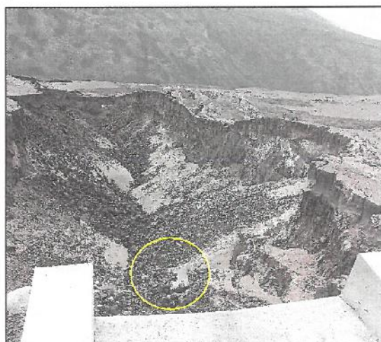
Imagen n.º 4 y 5: Se verificó que parte de la estructura de concreto construida para la limpia y evacuación del agua proveniente del reservorio, habría colapsado producto de la socavación del agua soltada del reservorio a través del citado canal. Asimismo, se verificó que el agua que se soltó por este canal de purga ha socavado este cauce, correspondiente a un suelo conformado principalmente por arenas y limos, socavando el terreno en un ancho aproximado de 7 metros y a una profundidad aproximada de 3 metros.
