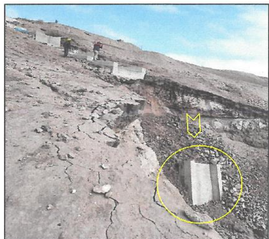
Imagen n.º 4 y 5: Se verificó que parte de la estructura de concreto construida para la limpia y evacuación del agua proveniente del reservorio, habría colapsado producto de la socavación del agua soltada del reservorio a través del citado canal. Asimismo, se verificó que el agua que se soltó por este canal de purga ha socavado este cauce, correspondiente a un suelo conformado principalmente por arenas y limos, socavando el terreno en un ancho aproximado de 7 metros y a una profundidad aproximada de 3 metros.
