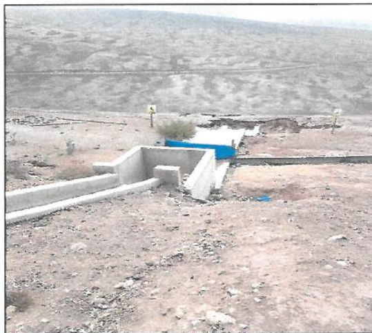
Imagen n.º 2: Cámara, canal de evacuación y badén de concretos ejecutados para el transporte, descarga y evacuación de los sedimentos sólidos en suspensión, decantados y retenidos como excedencias de agua del reservorio hacia una quebrada.
