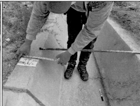
Imagen n.º 6: Vista de las medidas tomadas en el espesor del canal trapezoidal e=16.5\text{cm} .
