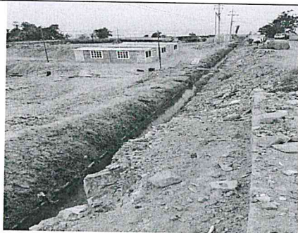
Fotografía N° 7: Vista de tramo de canal en Ensenada Mollendo
