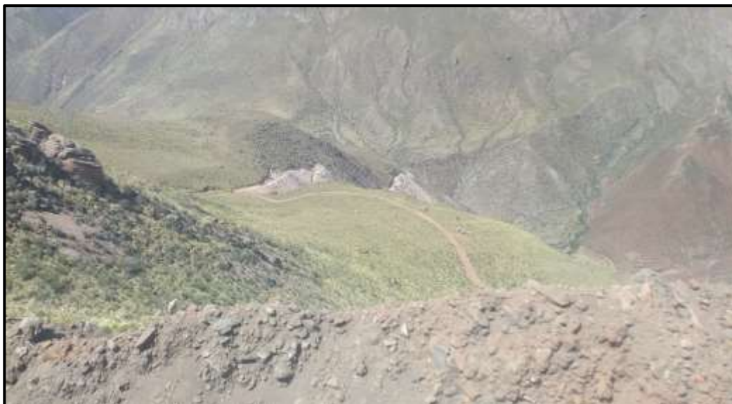
Imagen N° 5 Actividad de movilización (habilitación de accesos) al eje de presa
