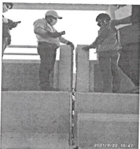
Fotografía n.º 9: Se aprecia la separación de la junta de separación sísmica es de 11 cm.
