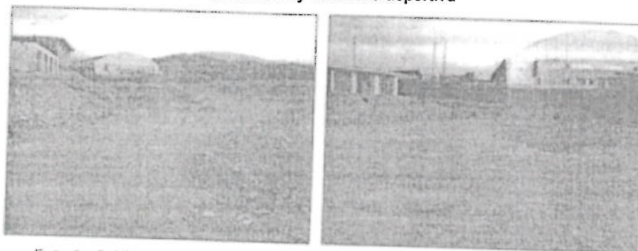
Foto 1 y 2: Vista del lado sur de la Institución Educativa, donde se construirá la ampliación el nivel inicial y la cancha deportiva.
