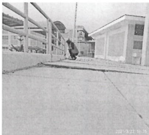
Fotografía n.º 19: Se aprecia la verificación de las juntas de separación sísmica.
