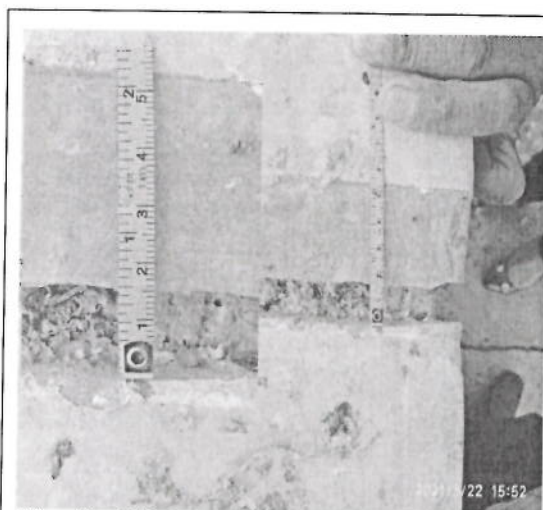
Fotografía n.º 10: Se aprecia la separación de la junta de separación sísmica Incrementada a 5.3 cm.
