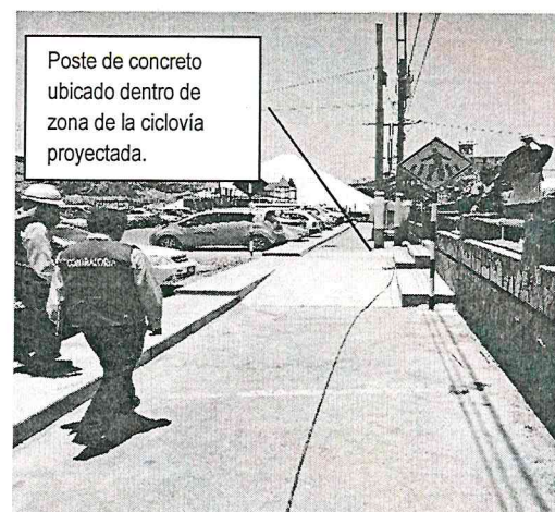
TOMA FOTOGRÁFICA N° 12 ZONA DE CICLOVÍA (PLAYA 2)
